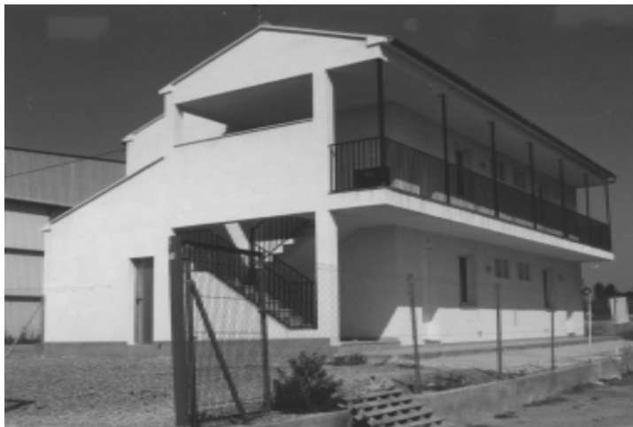
Alberg de l'Ajuntament del Torricó per acollir als treballadors temporals
