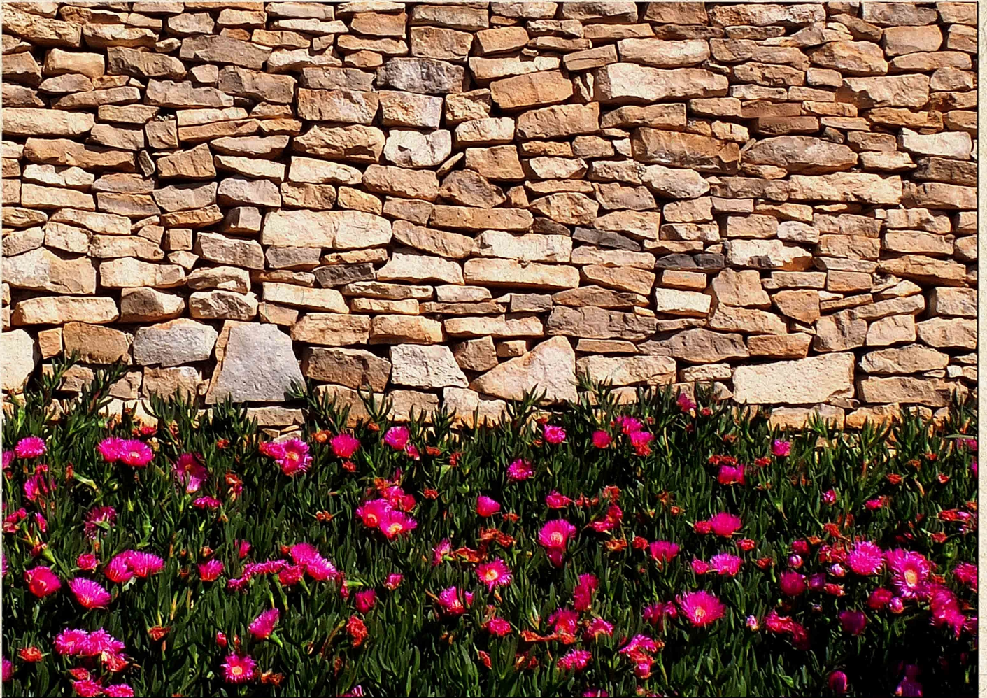
Paret de pedra seca. Autor: Ramón Mesalles.
